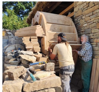
Realizace vodního kola valchy (Foto Martin Novotný)
