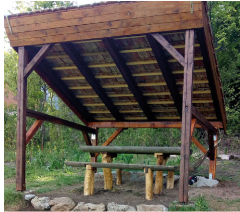
Prístrešok pod Babkami po obnove (Foto Jozef Figur)
