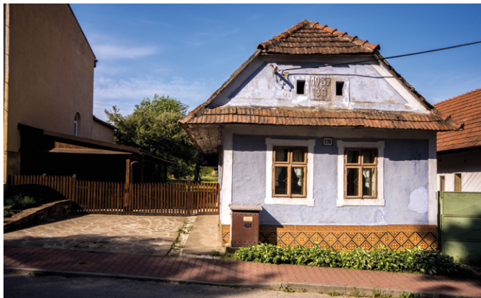
Izba pred rekonštrukciou (Foto Pavol Vandelia)
