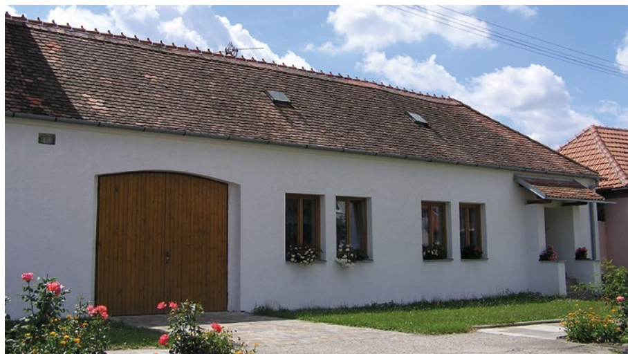
Původní, citlivě rekonstruovaný domek v centru vesnice (Foto archiv Správy CHKO Bílé Karpaty)
